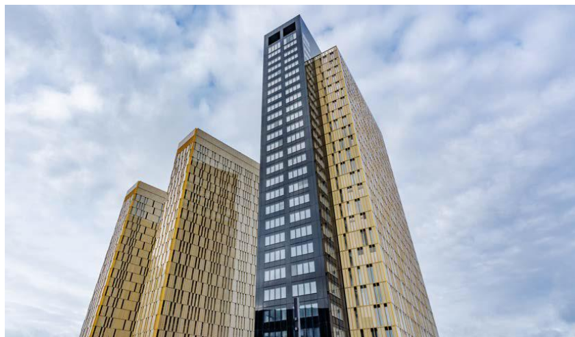
Les tours A, B, C de la Cour sont désormais dénommées Comenius, Montesquieu et Rocca.
